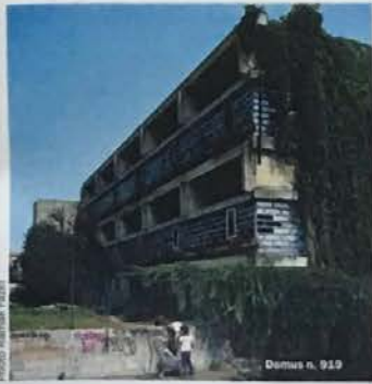
2008 Le nuove modalità di accesso all'Istituto Marchiondi a Milano./New access to the Istituto Marchiondi in Milan
